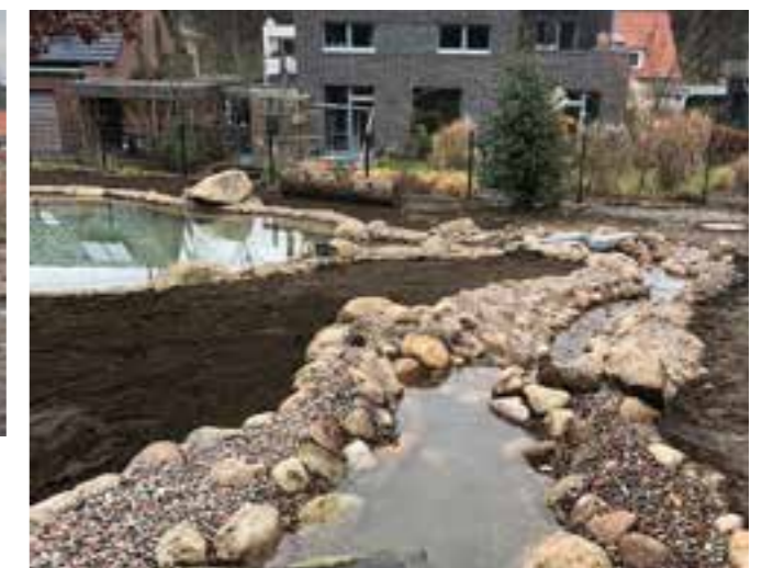
Das Projekt steht im starken Kontrast zu den geradlinigen Living Pools. Hier wurde ein Bachlauf mit alten Elementen, wie Sandsteintrögen, gebaut. Der Bachlauf endet in einem Teich. Als nächster Schritt stehen auch hier die Rasen- und Pflanzarbeiten an.
